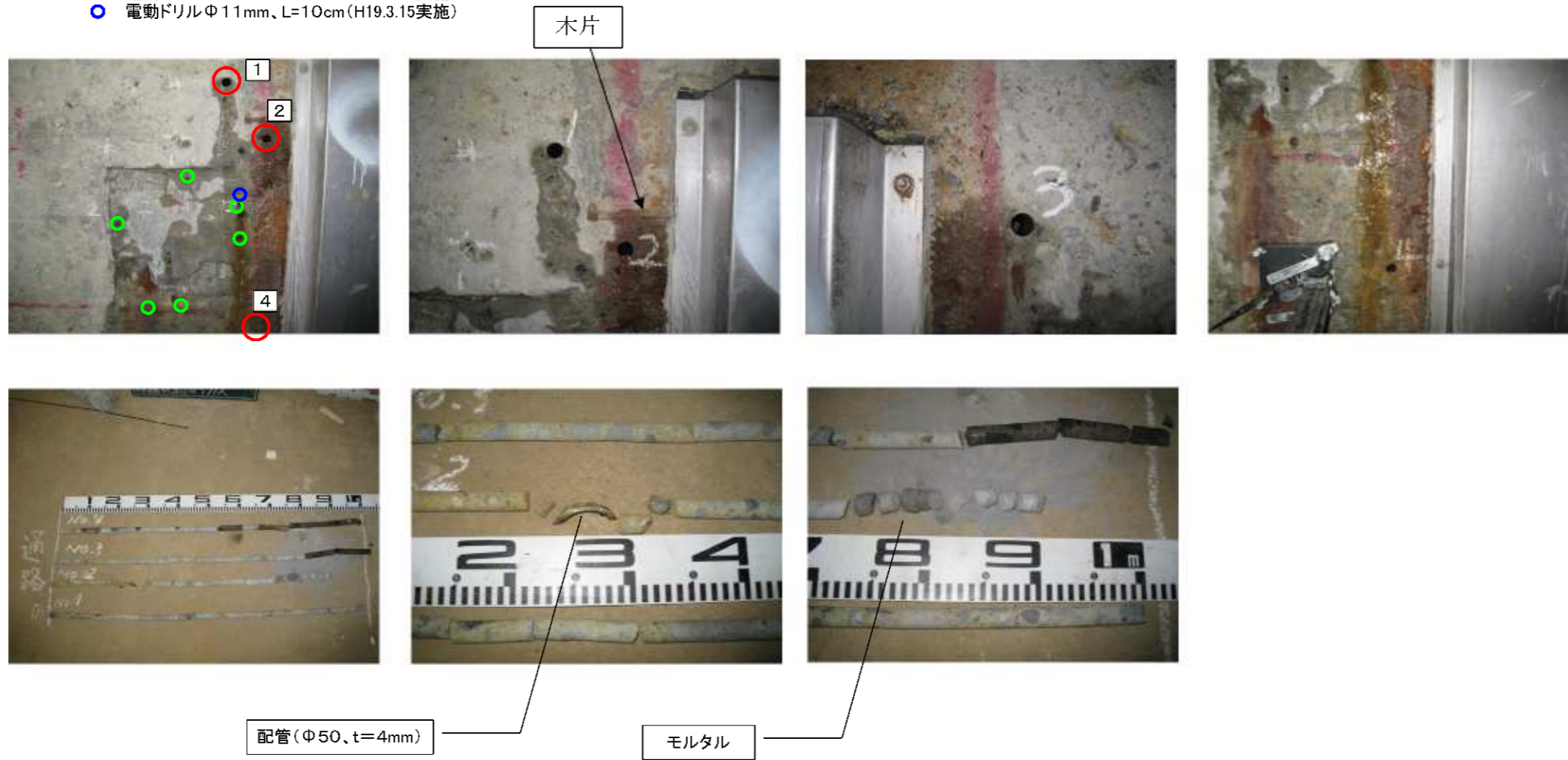
写真－ 1.1.19 旧揚圧力配管箱抜部周辺調査状況(H20/2)
