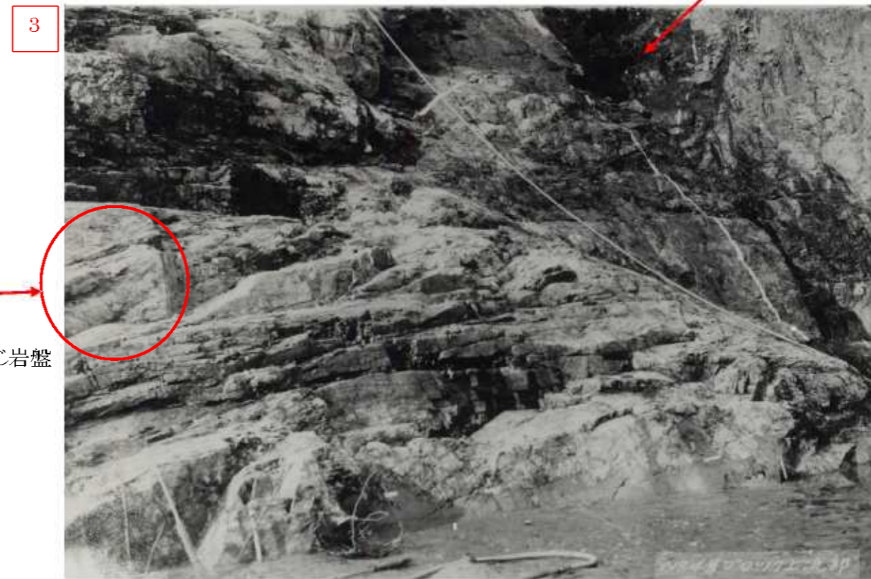
写真 - 1.1.11 No.4号ブロック上流部(第6回岩盤検査) S28.3.5
