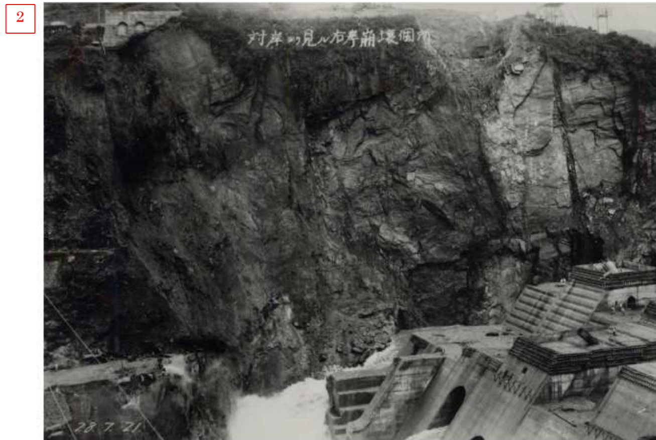
写真 - 1.1.14 右岸崩落状況(出水後)(昭和 28 年 7 月 21 日)
