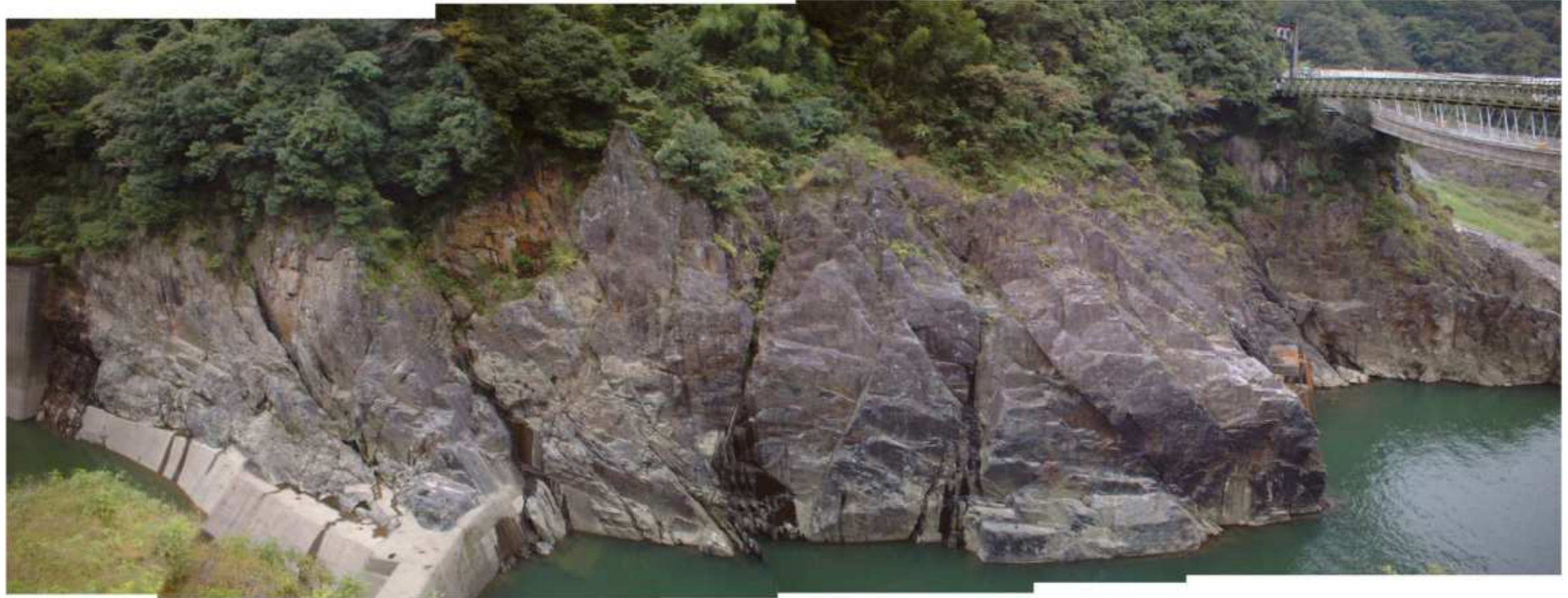
写真一 3.1.1 丸山ダム減勢工部の露岩状況（堅硬な岩盤が分布する） 右岸から左岸を望む
