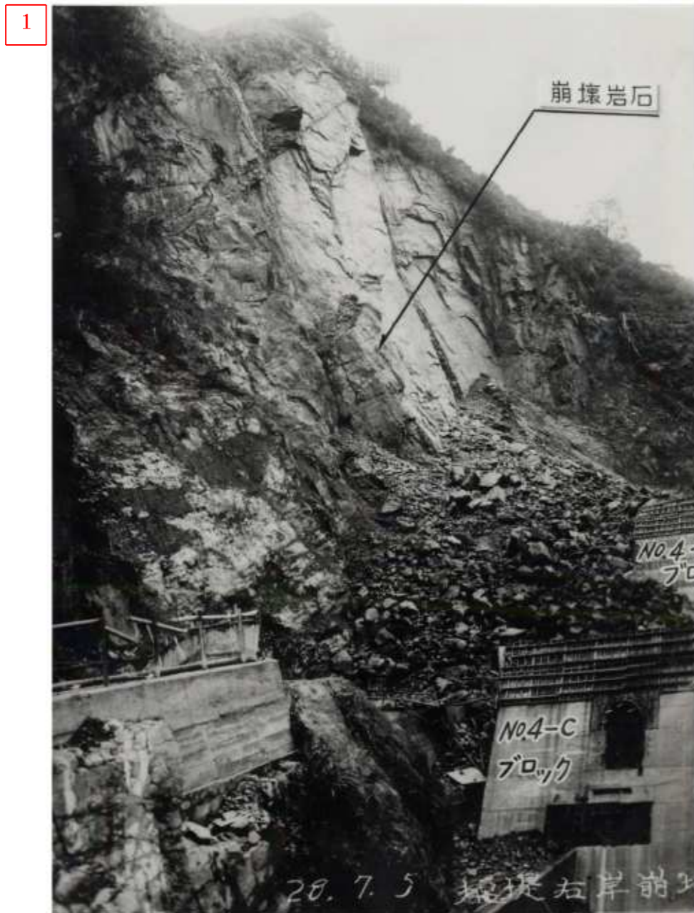
写真 - 1.1.13 右岸崩落状況(出水前)(昭和 28 年 7 月 5 日)
