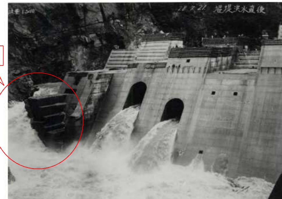
写真-1.1.12 右岸崩落ならびに洪水状況(昭和28年7月20日出水)
