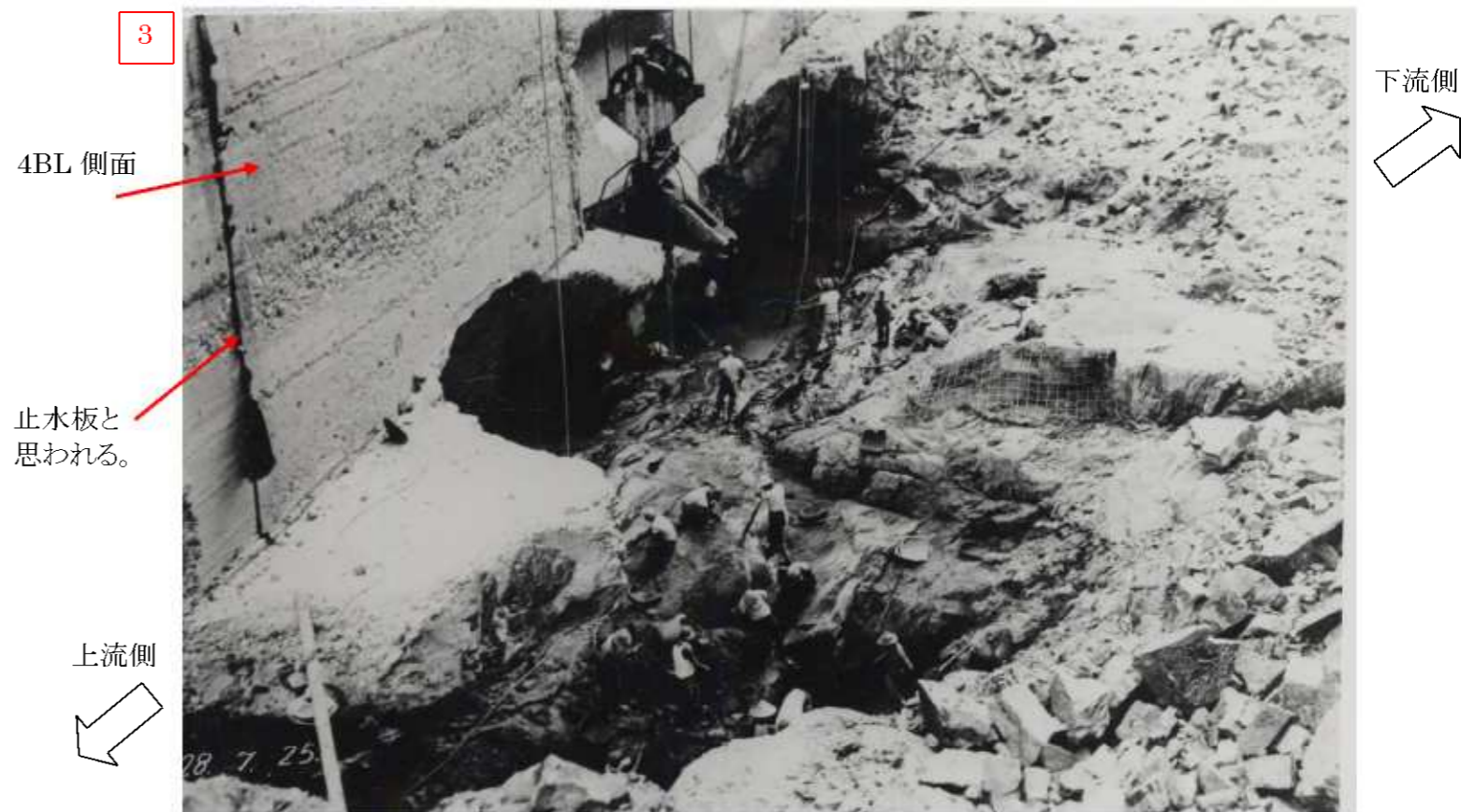
写真 - 1.1.15 第 9 回岩盤検査 (昭和 28 年 7 月 25 日)
