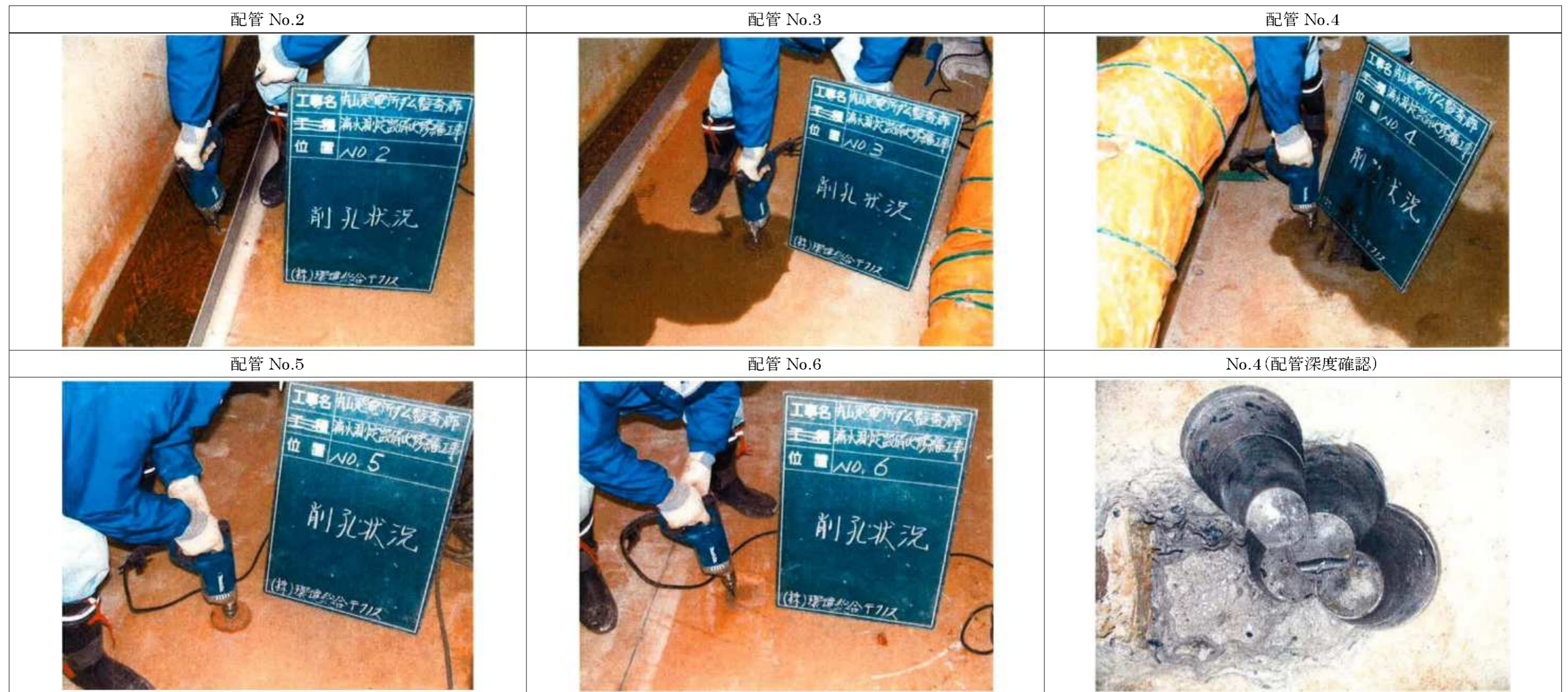
写真 - 1.1.10 旧揚圧力配管調査状況
